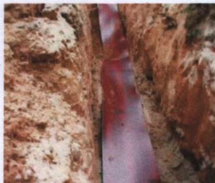
Рисунок 4 - Технология укладки ленты защитно-сигнальной в траншею
