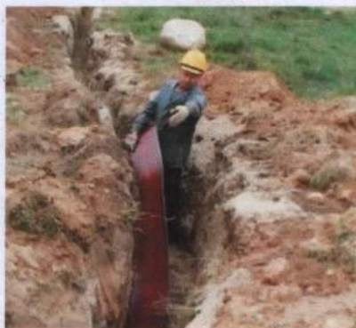
Рисунок 4 - Технология укладки ленты защитно-сигнальной в траншею
